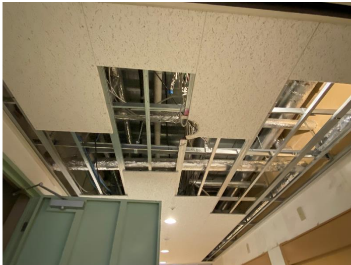
② 空調配管工事(3階)
