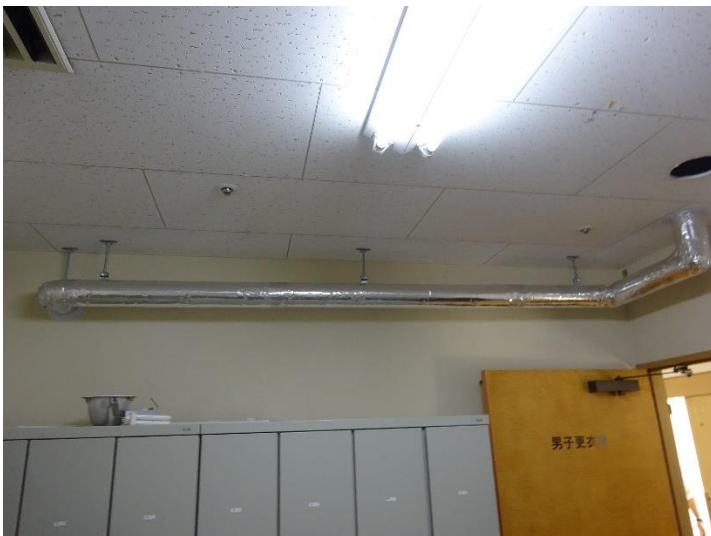
③空調配管の新設（3階男子更衣室）
